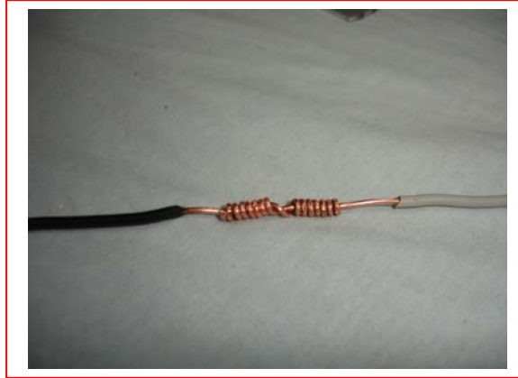
รูปที่ 10 งานสำเร็จการต่อสายแบบสายเดี่ยว
