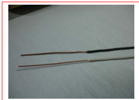
รูปที่ 7 ได้สายไฟที่ปอกฉนวนออกยาว 7 ซม.
