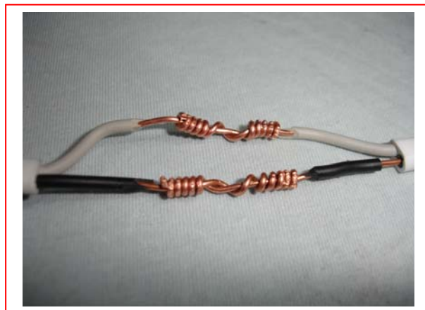
รูปที่ 4 ชิ้นงานสำเร็จ การต่อสายไฟแบบสายคู่
